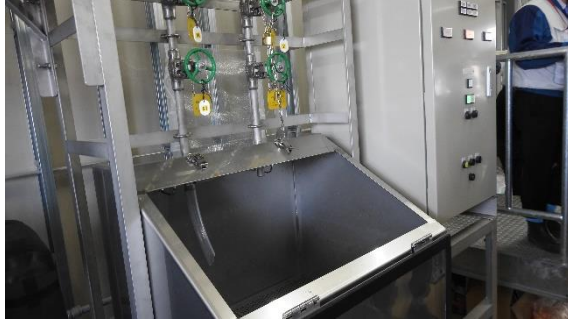
(写真 1 - 1) 試料採取に使われたサンプリングラックの状況
