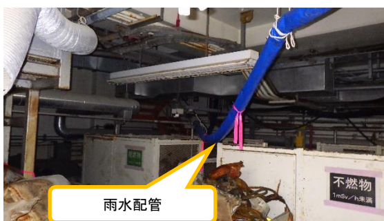
(写真3-2) 雨水配管の敷設状況 (1号Rw/B 入口付近)
