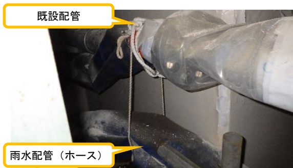
(写真3-1) 既設配管との接続状況 (1号Rw/B 内部)
