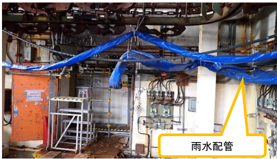
(写真2-2) 雨水配管の状況② (1号Rw/B西 側)
