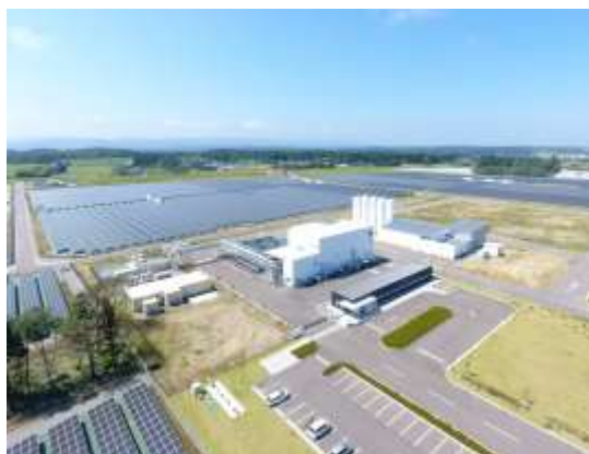
◆福島水素エネルギー研究フィールド（提供:NEDO）
