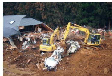
▲土砂崩れ（白河市）
