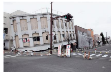
▲地震で倒壊した建物（須賀川市）
