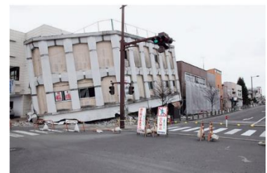
▲地震で倒壊した建物（須賀川市）
