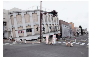
▲地震で倒壊した建物（須賀川市）
