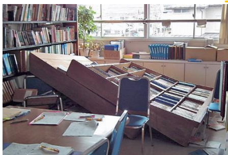
▲本棚の転倒（盲学校）
