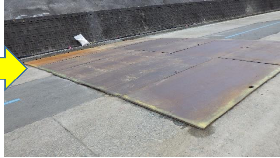
(写真 2 - 2) 発進立坑の状況② (今回(2月20日)北側から撮影)
