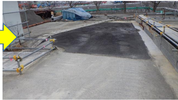
(写真 2 - 4) 到達立坑の状況② (今回(2月20日)南側から撮影)
