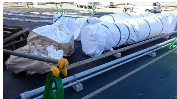
(写真 3-2) 撤去された排気管の仮置き状況
