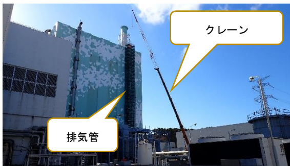
(写真 3-1) 6号機原子炉建屋北側におけるHPCSディーゼル発電機排気管撤去の状況
