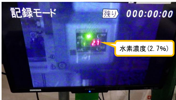
(写真1-2) 遠隔操作室内のモニタの状況
