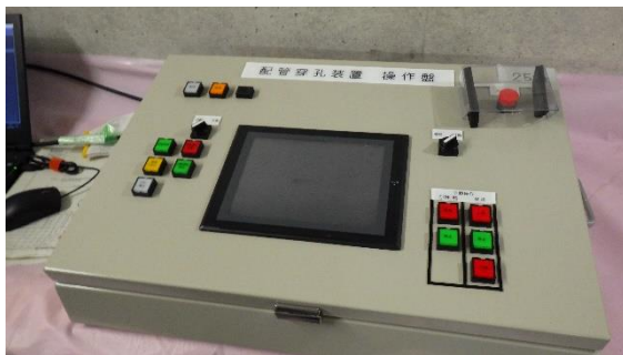
(写真2) 穿孔作業に使用する操作盤
