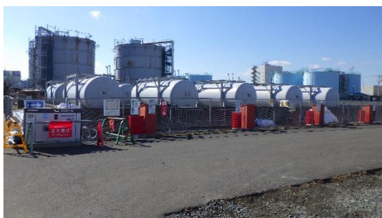
(写真1-1) 絶縁油タンクエリア (Dタンク エリア西側) の概観 (北東側から撮影)
