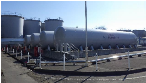
(写真3-1) 絶縁油タンクエリア（正門東側）の の概観 （北西側から撮影）
