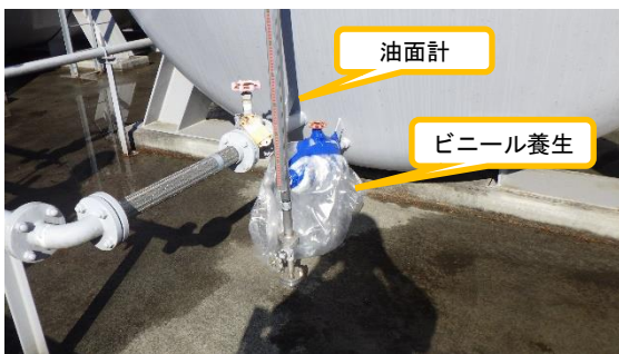
(写真3-2) 絶縁油タンクエリア（正門東側）に 設置されている絶縁油タンク油面計 の元弁部周囲の養生の状況
