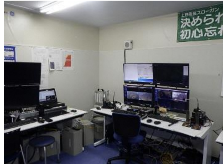
<情報棟遠隔操作室>
