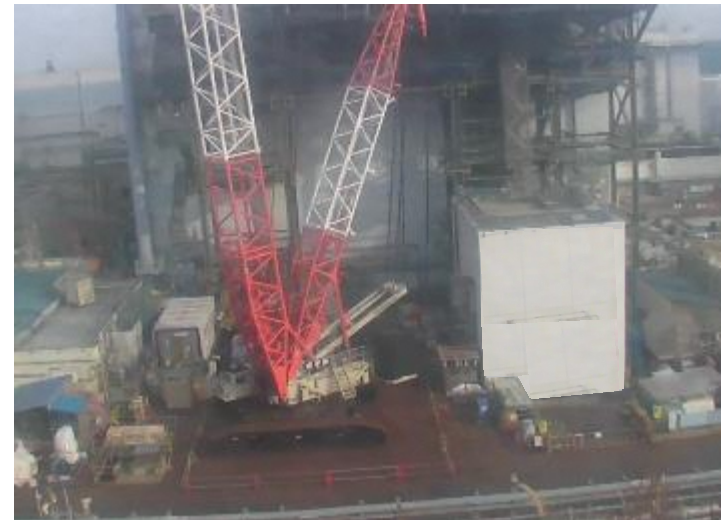
<大型クレーン>
