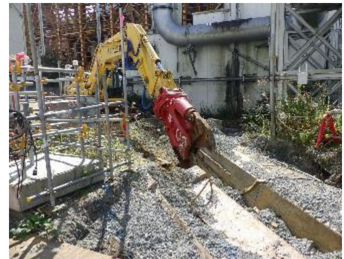
<遠隔操作重機>
