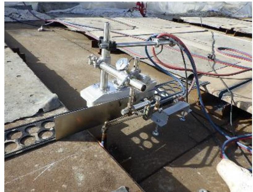
<自走式溶断機による鉄板切断>
