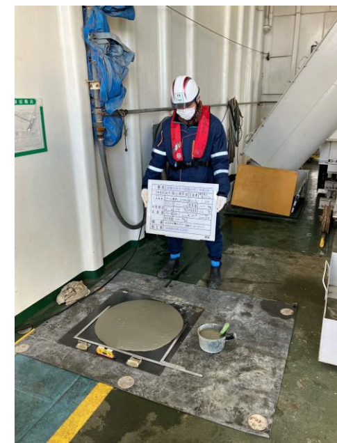
水中不分離モルタル （品質確認）
