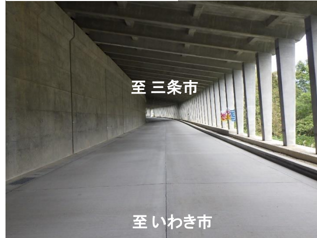
スノーシート工事状況
