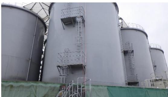
(写真1) Dタンクエリアの概観
