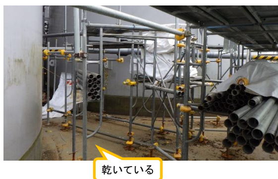
(写真5) Dタンクエリアの内堰内の状況の例
