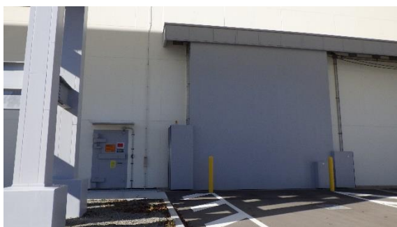
(写真1) 搬入口の状況
