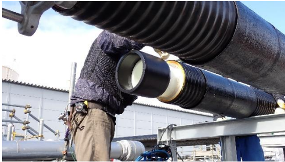
(写真1) 配管の融着作業の状況
