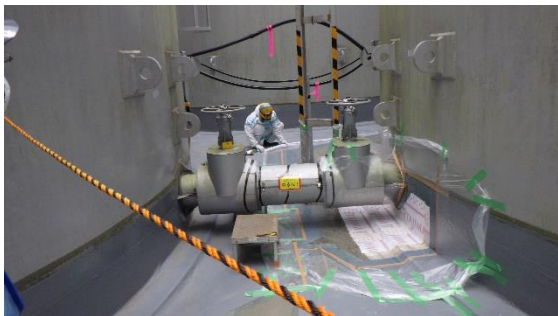
(写真3) タンク底部の養生作業の状況
