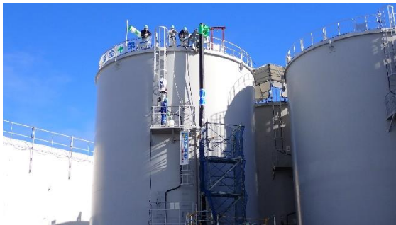
(写真2) 配管の水張り作業
