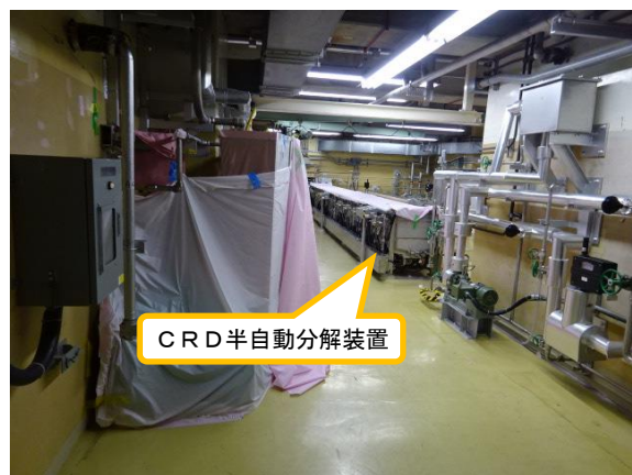
(写真1-2) 除染後のCRD補修室内の状況 (令和4年6月24日撮影)
