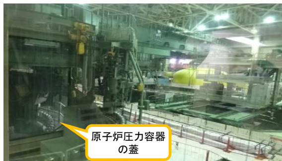
(写真2-2) オペレーティングフロア内の状況②
