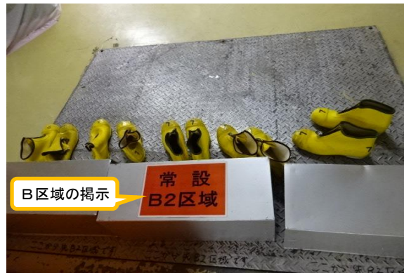
(写真1-4) 除染後のCRD補修室入口の状況 (令和4年6月24日撮影)
