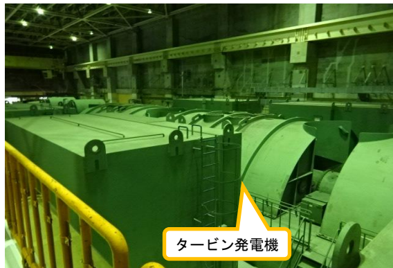
(写真3-1) タービン建屋内の状況
