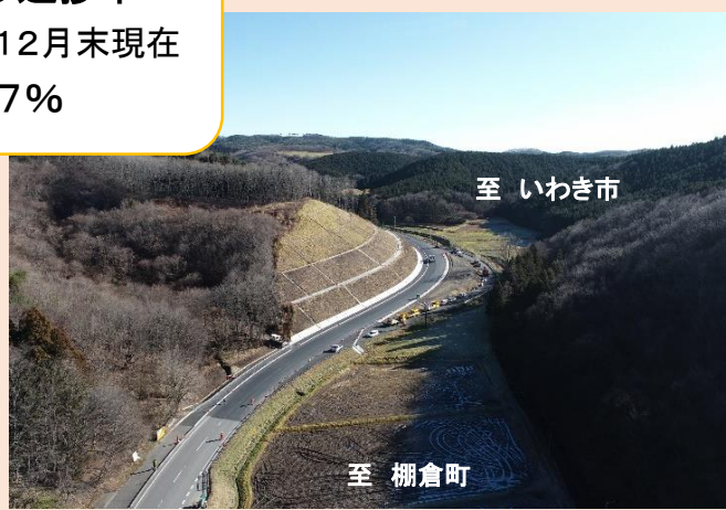
① 2工区 舗装完了箇所 (バイパス部の舗装を行いました)
