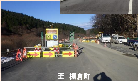
② 2工区 路面掘削状況 (片側交互通行)
