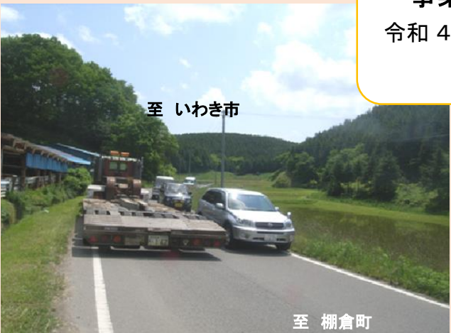
工事着手前(平成25年度)
