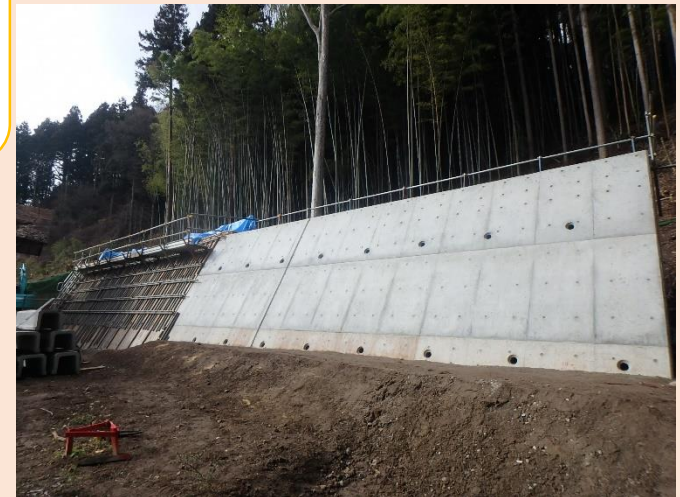
施工状況写真
