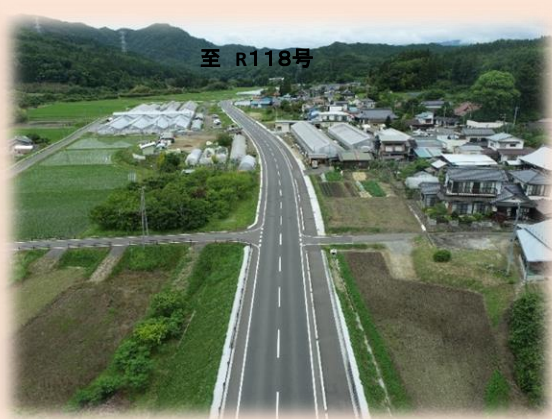
②整備後(2工区)
