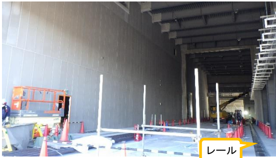
(写真3) 大型金属処理室内の状況
