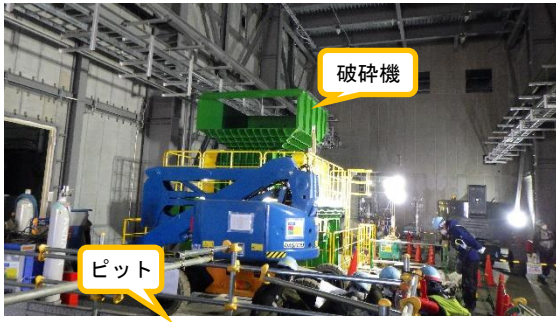
(写真4-2) コンクリート減容処理室内の状況
