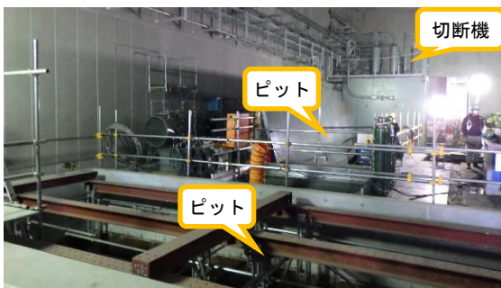
(写真4-1) 金属減容処理室内の状況
