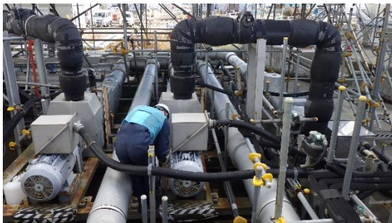
(写真 3) ポンプ起動の確認状況
