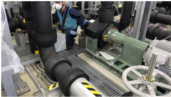
(写真7) ポンプ起動の確認状況
