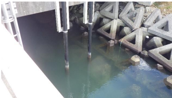
(写真8) サブドレン処理水排水口の状況
