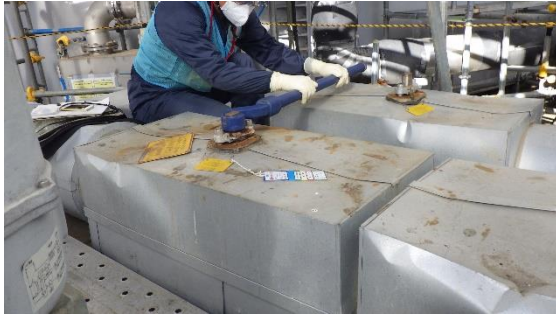
(写真 2-3) グループ 3 排水弁の「全開」作業状況
