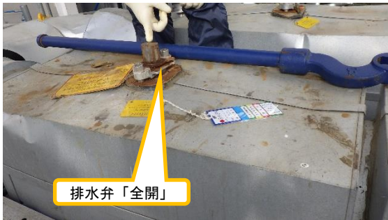
(写真 2-4) グループ 3 排水弁の「全開」状況
