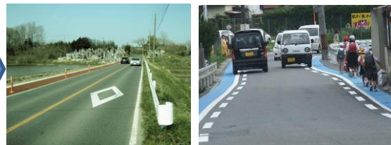
カラー舗装により路肩が確保された状況
