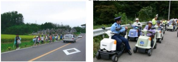
路肩幅員が不足している状況
