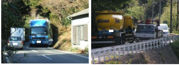
大型車のすれ違いが困難な状況
