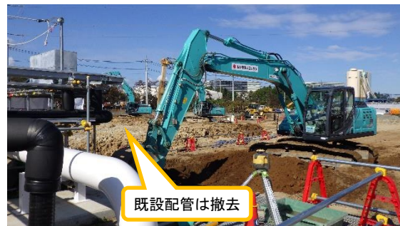
(写真1-2) エリア整備作業の状況① ・重機により地盤改良工事を実施 (令和4年10月28日)
