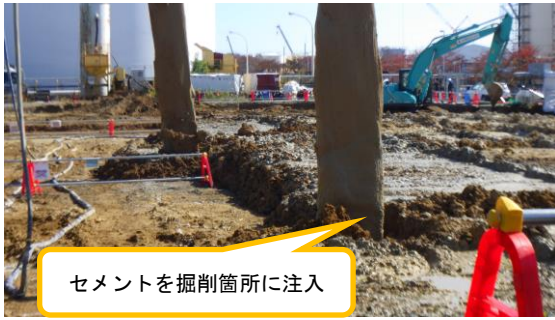
(写真 2 - 2) エリア整備作業の状況③ (写真 2 - 1 を拡大)
