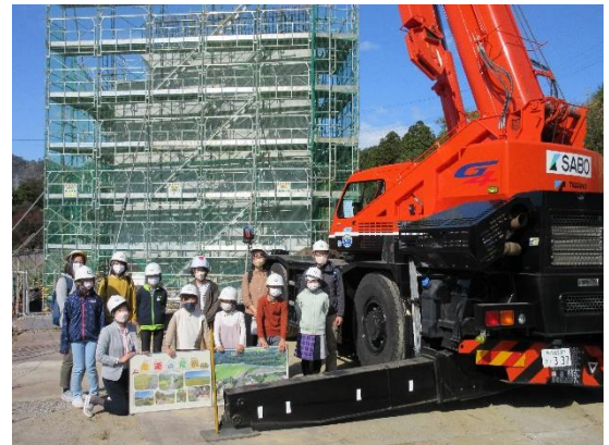
▲ 広域農道工事（橋梁工事）
