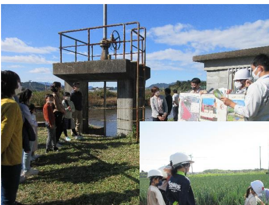
▲ 仁井田堰頭首工
