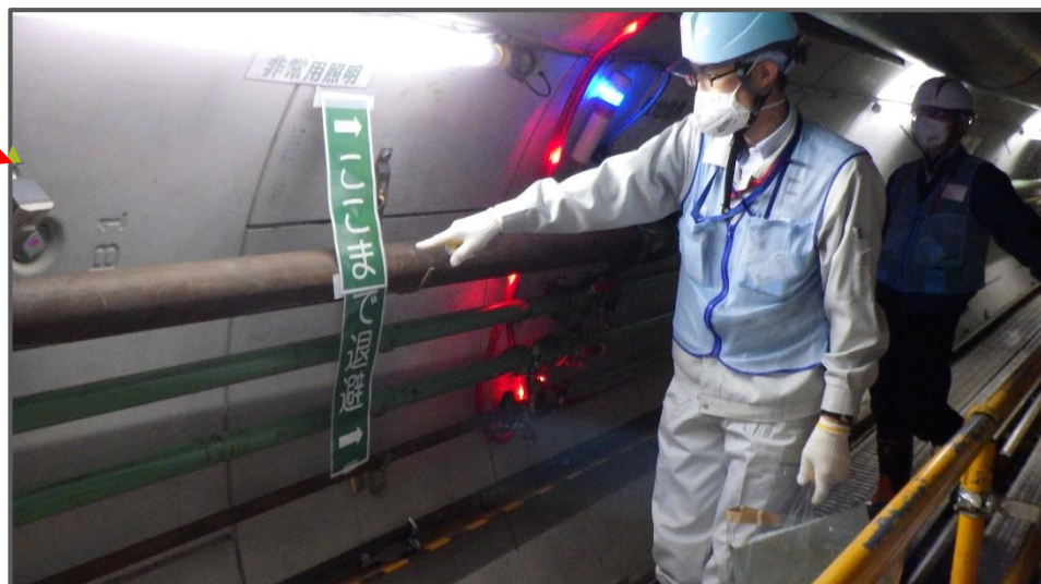
トンネル内待避所の状況
