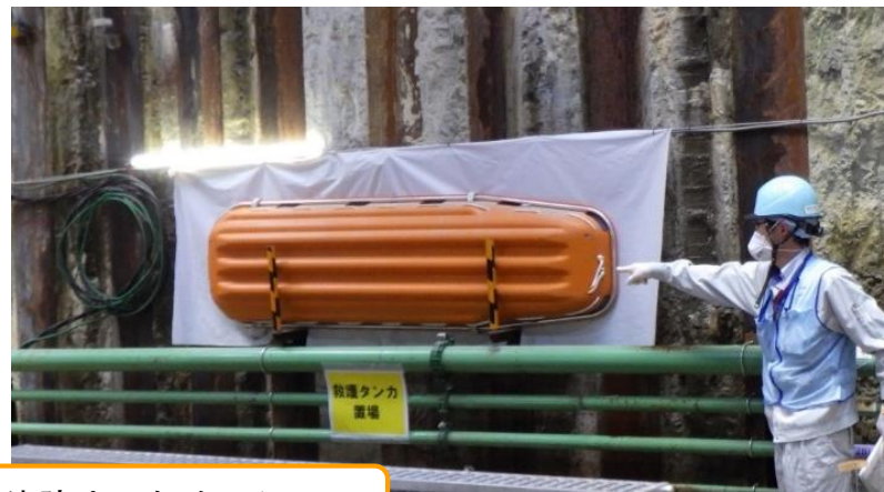
汚染防止のためのシート
