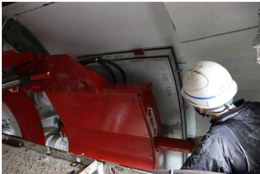
セグメント組立状況
