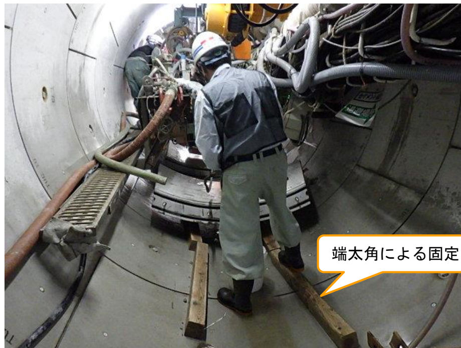
インバート部への仮置き状況
