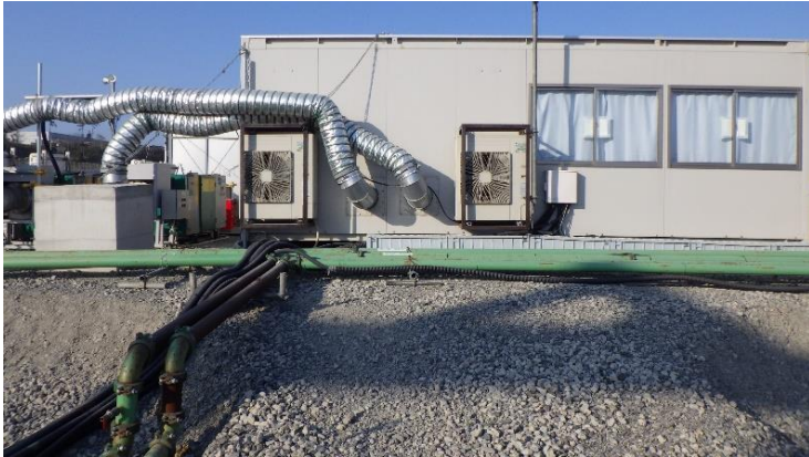
休憩所の設置状況（飲食可能スペース、お手洗い設置）
