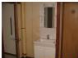
③洗面所へキャビネット洗面化粧台設置(シングルレバー混合水栓付き)
