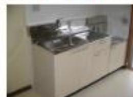
⑤台所の流し台更新(シングルレバー混合水栓付き)
