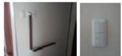
④玄関へ手すり設置
