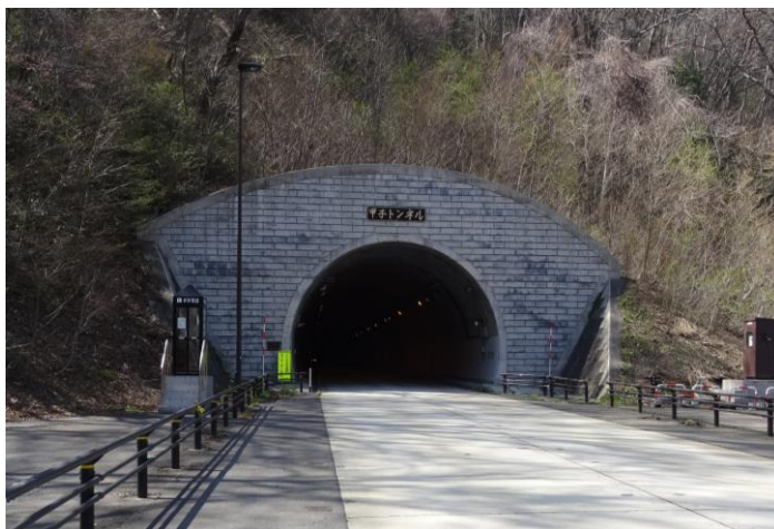
甲子トンネル西郷側坑口
