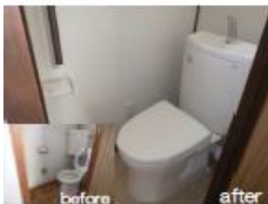
①便所の段差解消・便器更新・手すり設置
