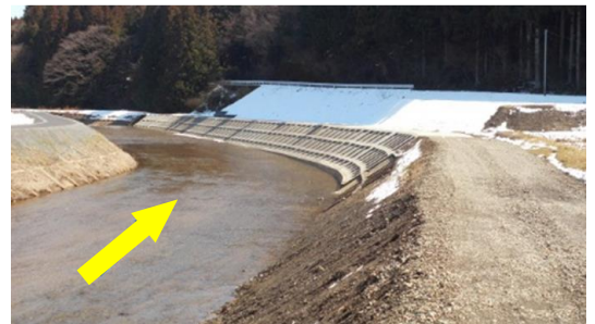
施工状況（令和4年3月24日撮影）
