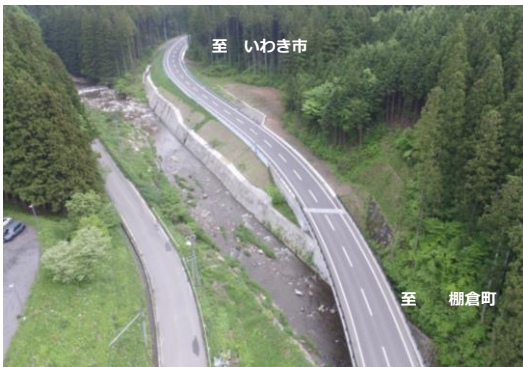
③鮫川村 (国道289号) 渡瀬バイパス整備
