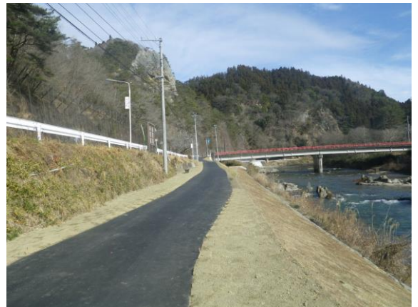
【R3 歩道設置完了】
