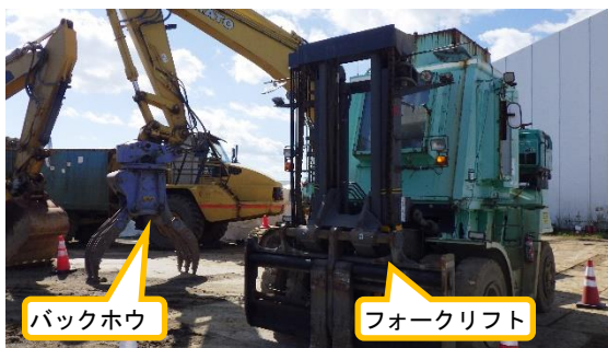
(写真3) 現場で使用する重機の状況
