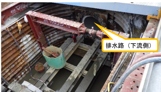
(写真 3 - 2) 発進立坑の中の状況 (北西側から撮影)
