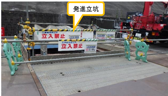
(写真 3 - 1) 発進立坑の概観 (北側から撮影)
