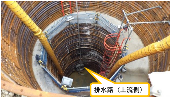
(写真 2 - 2) 到達立坑の中の状況 (南東側から撮影)
