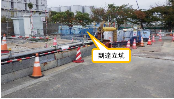
(写真 2 - 1) 到達立坑の概観 (南東側から撮影)
