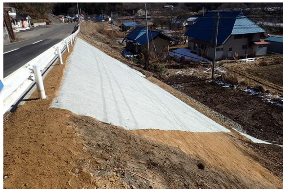
国道118号 天栄村大字田良尾地内 路肩崩落箇所を復旧しました。(令和元年12月片側交互通行解除)
