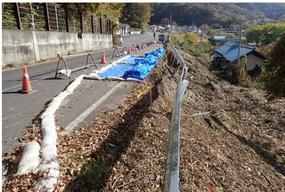
国道118号 天栄村大字田良尾地内 路肩崩落箇所を復旧しました。(令和元年12月片側交互通行解除)
