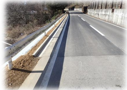
国道118号復旧箇所
