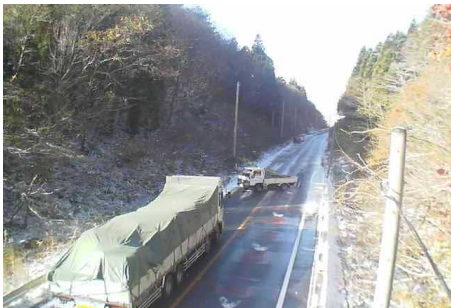
冬期交通支障状況1
