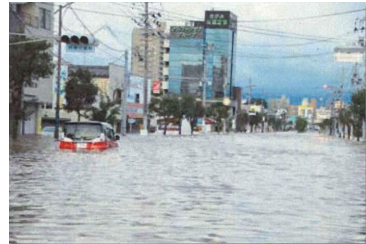
若葉町交差点浸水状況
