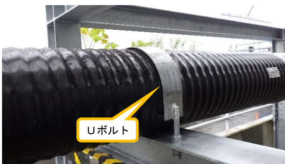
(写真3-1) 配管のサポートへの据え付け状況①
