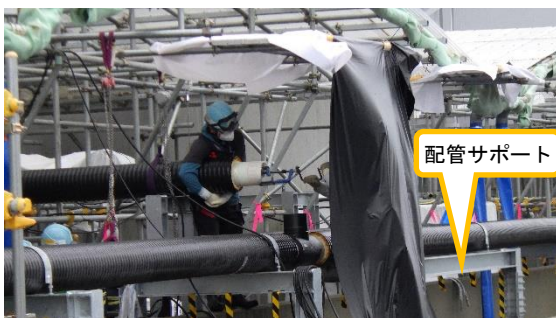
(写真2) 配管の融着作業の状況
