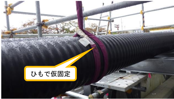
(写真3-2) 配管のサポートへの据え付け状況②
