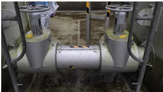
(写真4-2) 連結配管の状況 (保温材有り) ②
