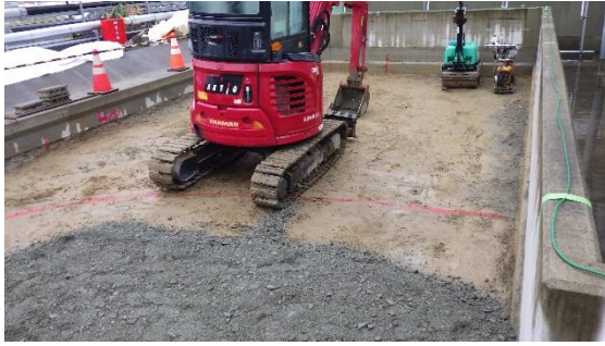
(写真5) K4タンクエリアの北東部における 基礎工事の状況
