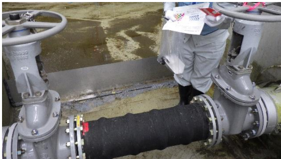
(写真4-1) 連結配管の状況①
