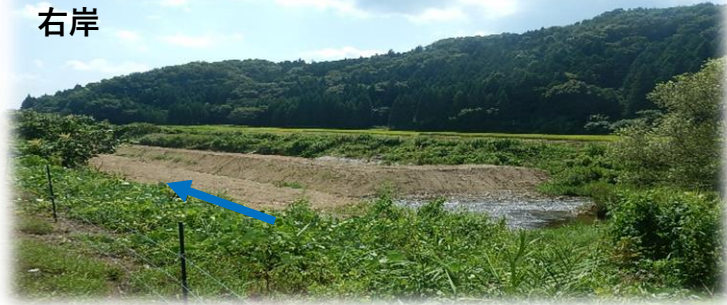
上流(左岸)から下流を望む
