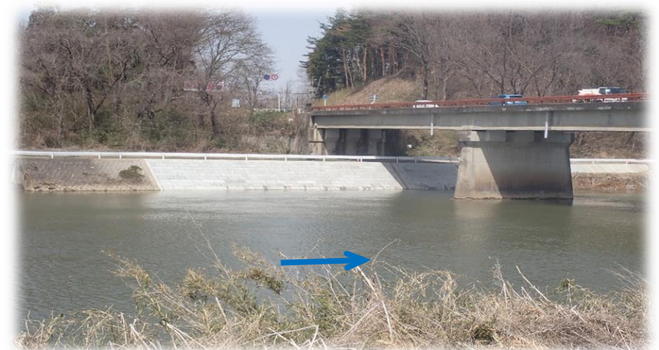
右岸から左岸を望む
