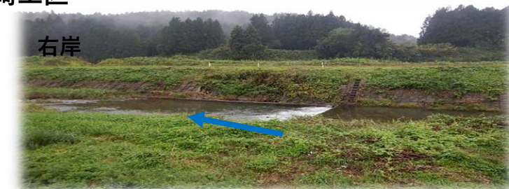
上流(左岸)から下流を望む
