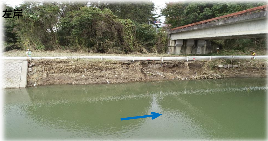
右岸から左岸を望む
