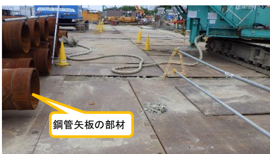
(写真 2 - 1) 放水立坑（上流水槽）の状況 (令和 4 年 8 月 22 日撮影)
