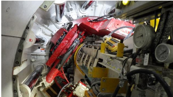
(写真 1 - 4) 放水トンネルの先端の状況
