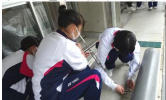
全校生で防水板の設置中
