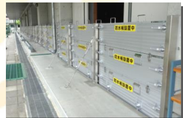
設置完了後の防水板
