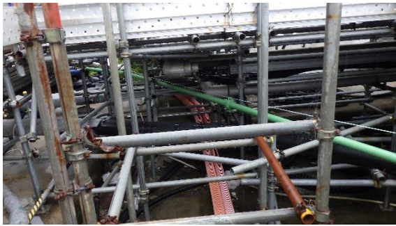
(写真 3) 作業用構台周辺の配管等の状況 (東側から撮影)
