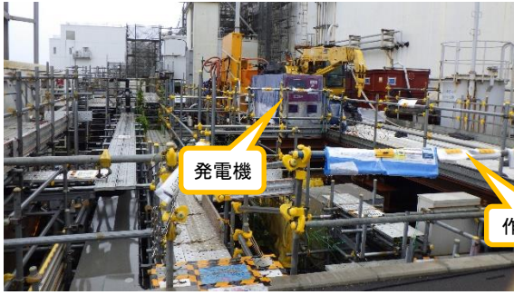
(写真 2 - 2) 薬液注入工事用機材の設置状況② (北側から撮影)
