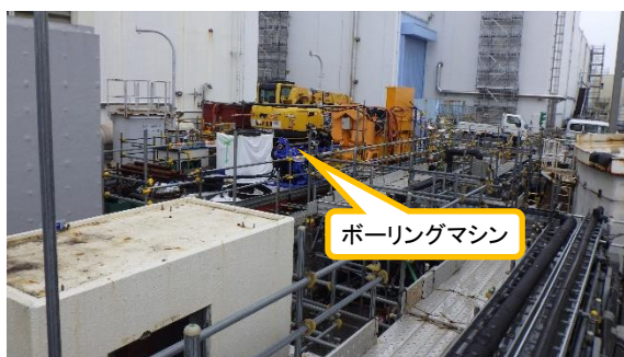
(写真2-1) 薬液注入工事用機材の設置状況① (南東側から撮影)
