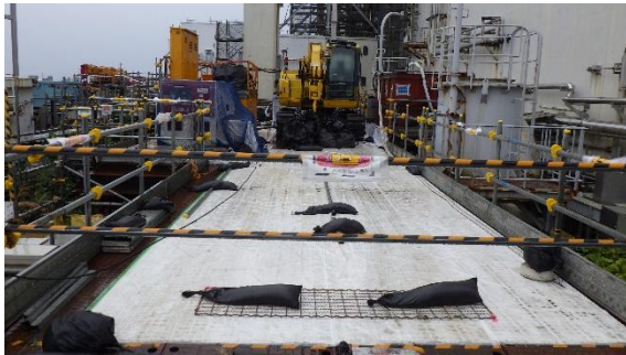
(写真 4) 資材の飛散防止対策の状況 (北側から撮影)
