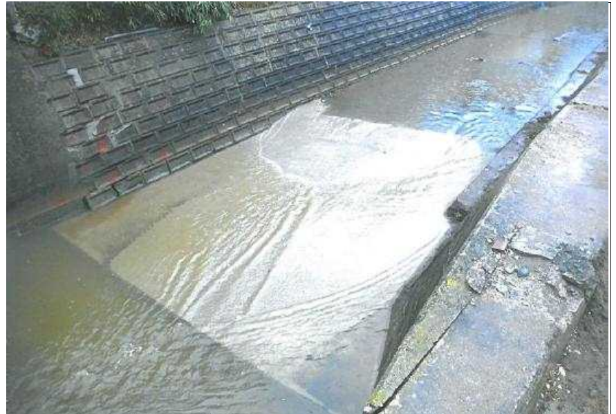
写真2-2 関田ポンプ場(いわき市) 流入渠底板復旧状況
