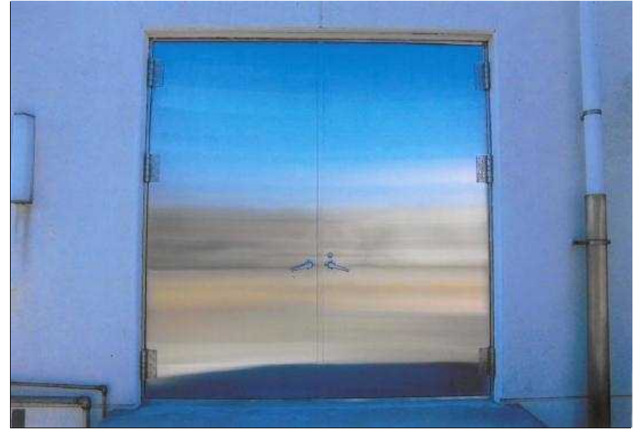
写真1-2 関田ポンプ場(いわき市) 大型引戸門扉復旧状況
