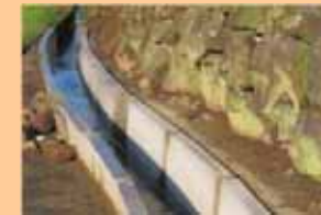
■ 素掘り水路からコンクリート水路への更新
