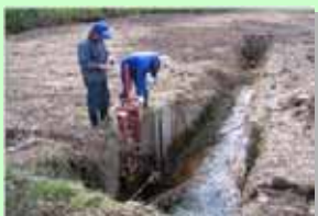
■ 点検・機能診断
