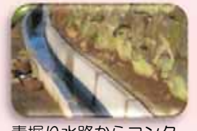
素堀り水路からコンクリート水路への更新 【活動例】
