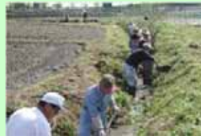
■ 水路の保全管理
