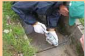
■ 水路の老朽化箇所の補修
