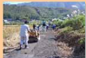
■ 農道舗装の補修
