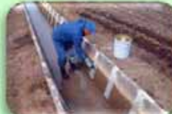
漏水箇所の目地補修等による水路の保安全管理
