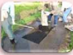
農道舗装の補修
