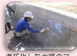
老朽化した水路のコーティング等による補修
