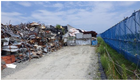
(写真2-1) 単管パイプとネットによるフェンスの設置状況①
