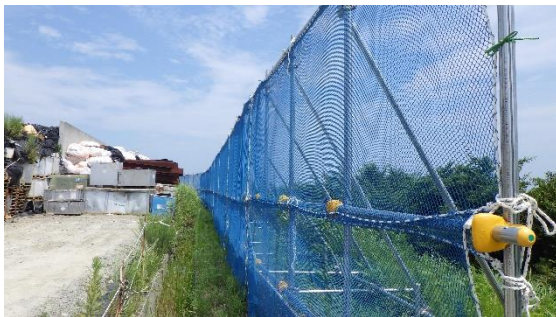
(写真2-2) 単管パイプとネットによるフェンスの設置状況②
