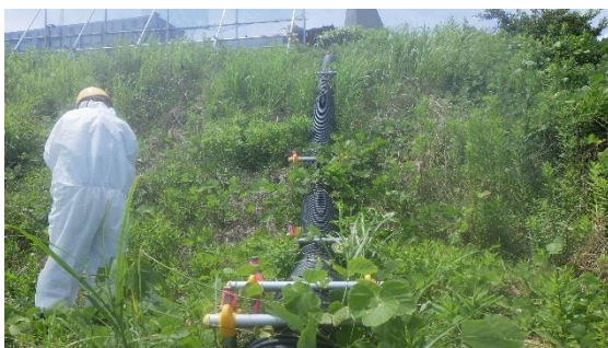
(写真3-1) 新たに設置された排水路の状況(一時保管エリアP東側法面から当該エリアに向かって撮影)
