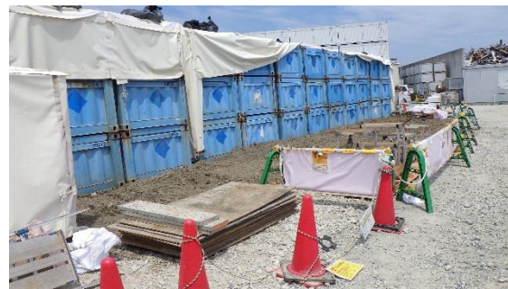
(写真1-2) ノッチタンクが設置されていた箇所の状況 (令和4年8月9日南東側から撮影)
