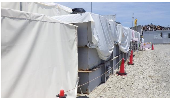
(写真1-1) ノッチタンクの設置状況 (令和4年6月30日撮影)
