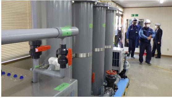
(写真 2 - 5) 海洋生物由来のアンモニアを分解する生物ろ過槽 (3 槽)
