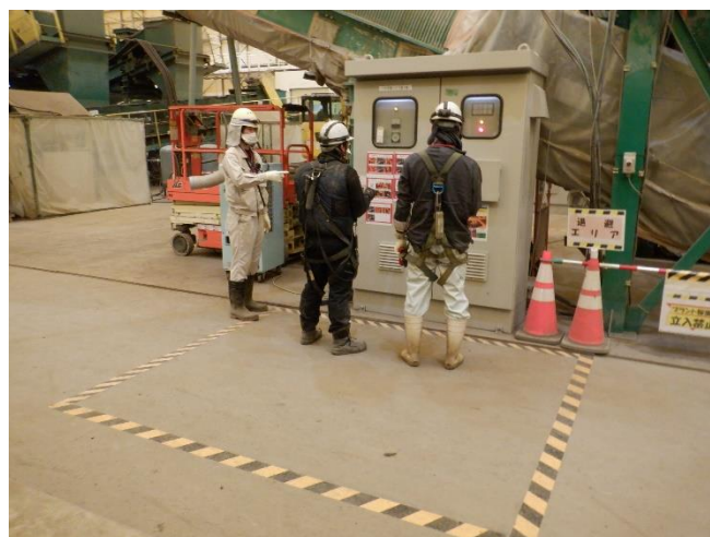
JV職員による退避確認
