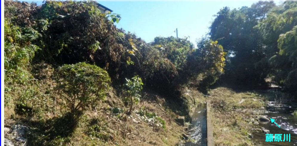
①藤原川 常磐藤原町別所地内 【施工前】
