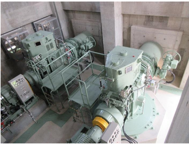
排水機場内のポンプ口径 1000mm×2台
