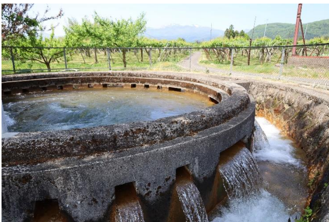
取り決めた量の水を配分するための円形分土工（福島市）
