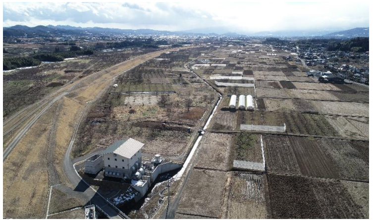
排水機場と受益地
