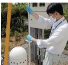
空間線量率の検出器の点検をする様子
