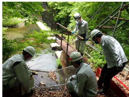
設備点検の様子
