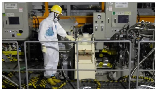
(写真4) HIC 代替フィルタ
