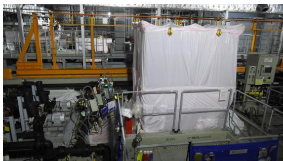
(写真3) HIC 移し替えハウスとダストモニタ
