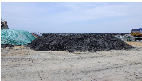
(写真2) 掘削された海底の土砂の状況
