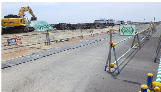
(写真1-2) 新設港湾ヤードの状況 (北側から撮影)
