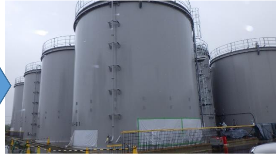
(写真3-2) 同左 (今回(6月7日)南東側から撮影)
