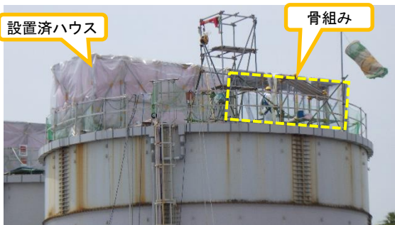
(写真2-1) D2タンク上部の状況 (北側から令和4年5月12日撮影)
