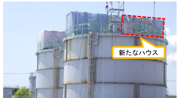
(写真2-2) D2タンク上部の状況 (北側から令和4年6月2日撮影)
