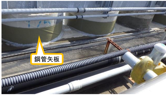
(写真1-1) 海側遮水壁の鋼管矢板の設置状況 (1号機タービン建屋東側付近)
