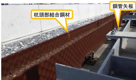
(写真1-2) 杭頭部結合鋼材の設置状況
