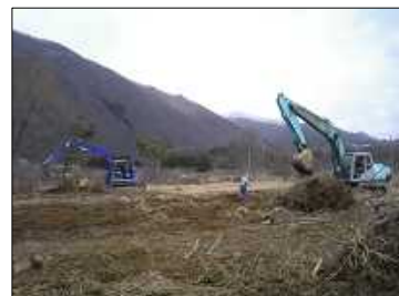
重機による整備
